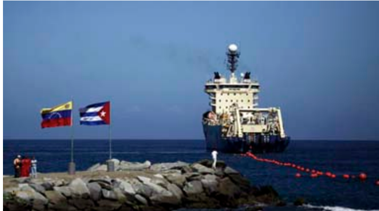
En enero, un buque realiza el tendido de fibra óptica que une a Venezuela con Cuba, un proyecto que facilitará Internet de alta velocidad en la isla. (AP/Ariana Cubillos)
